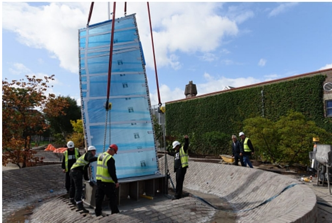
Installatie van 'Sky Mirror (for Hendrik)' voor de entree van De Pont
